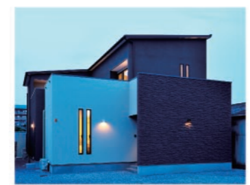
「いつまでも飽きないよう、違った素材を組み合わせ て表情をつけたい」と、外壁にはタイル、石、杉板をバ ランスよく配した。
